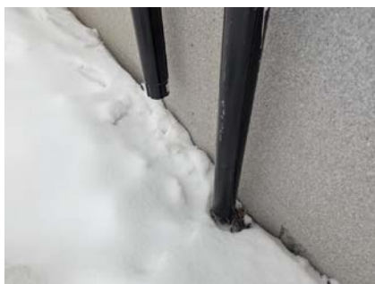
Taknedløp til terreng nær bolig
