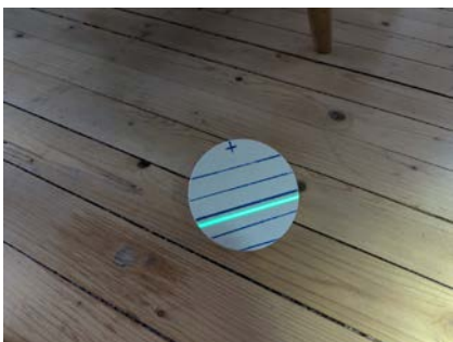
Måling av skjevhet/retningsavvik på gulv i stue 2. etg
