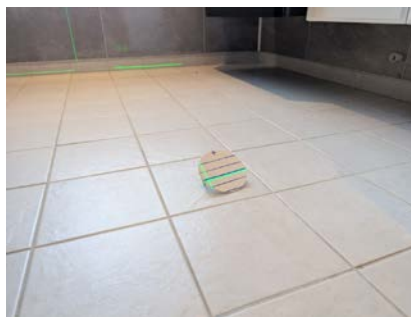
Måling av fallforhold på gulv
