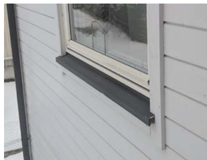
Utvendig vannbrett / vindusomramming
