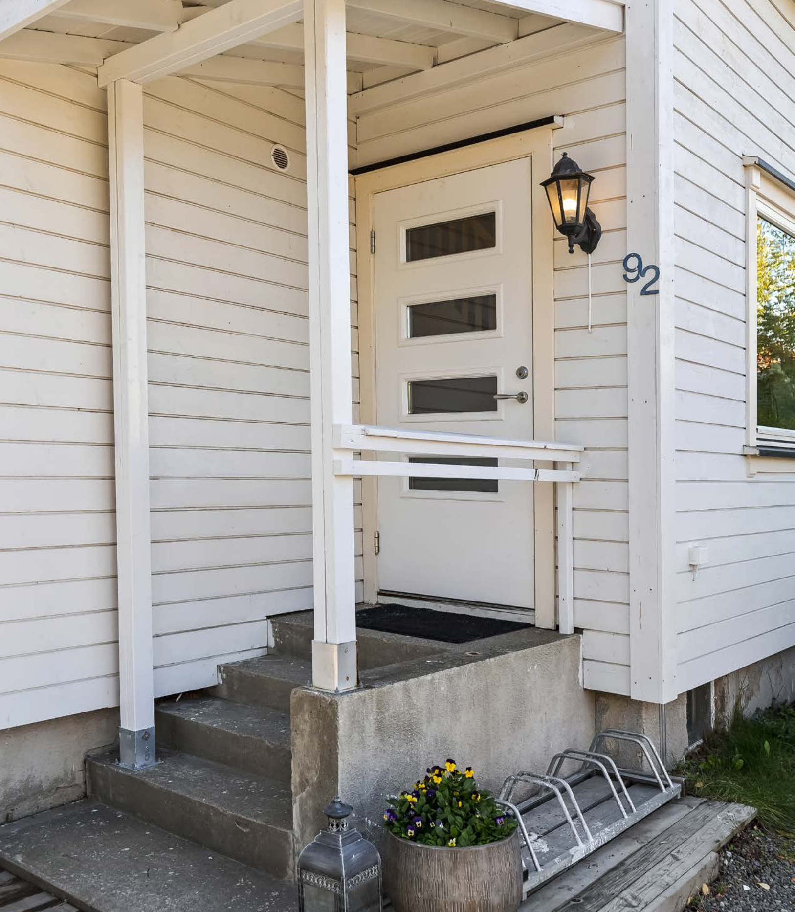
Du ønskes velkommen inn til felles trapperom via et overbygget inngangsparti med trapp.
