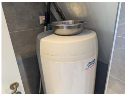
Varmtvannsbereder
