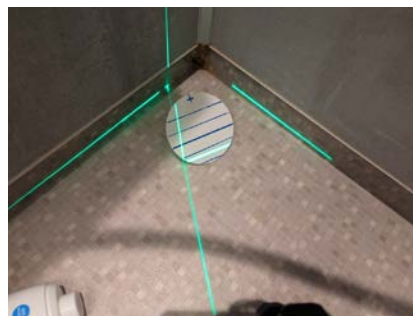
Måling av lokalt fall mot sluk
