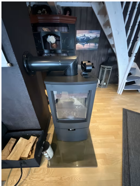
Viser ildsted montert i stue.
