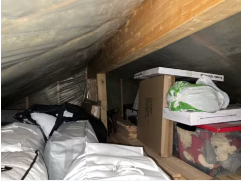
Viser loft med adkomst via dør i knevegg på soverom.
