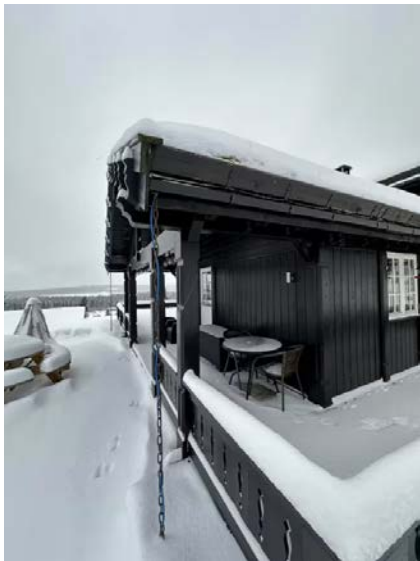
Viser takrenne, nedløp med kjetting og varmekabel.
