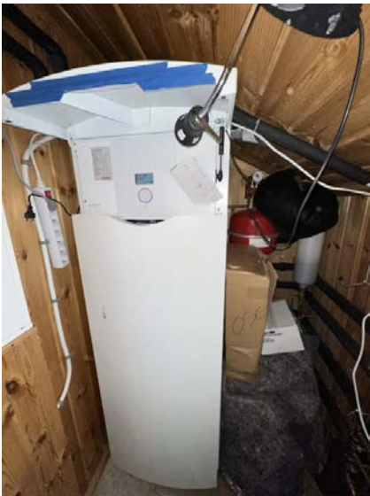
Thermia Diplomat bergvarmepumpe for gulvvarme og forbruksvann.
