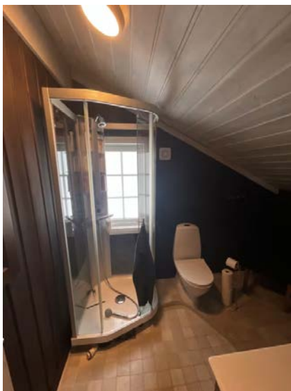
Viser dusjkabinett og gulvstående toalett.
