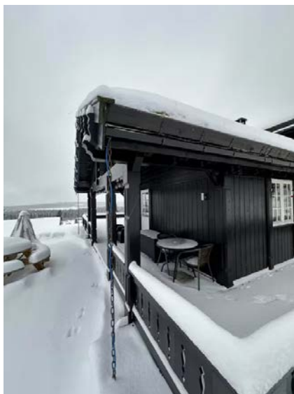
Viser takrenne, nedløp med kjetting og varmekabel.
