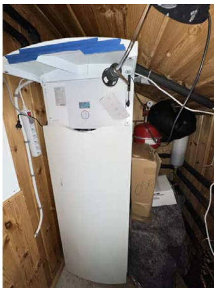
Thermia Diplomat bergvarmepumpe for gulvvarme og forbruksvann.
