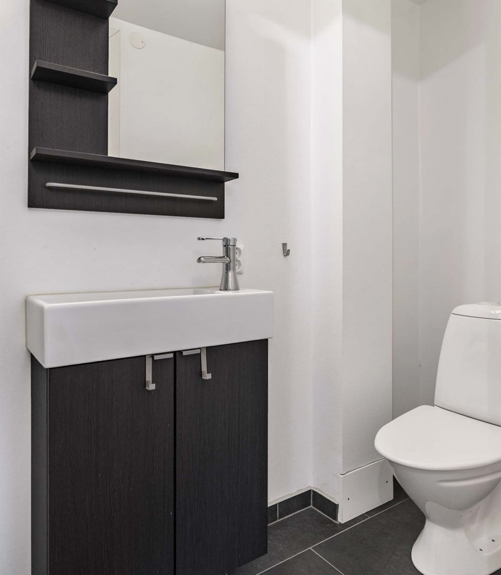
Innredet som bad men ikke godkjent.
