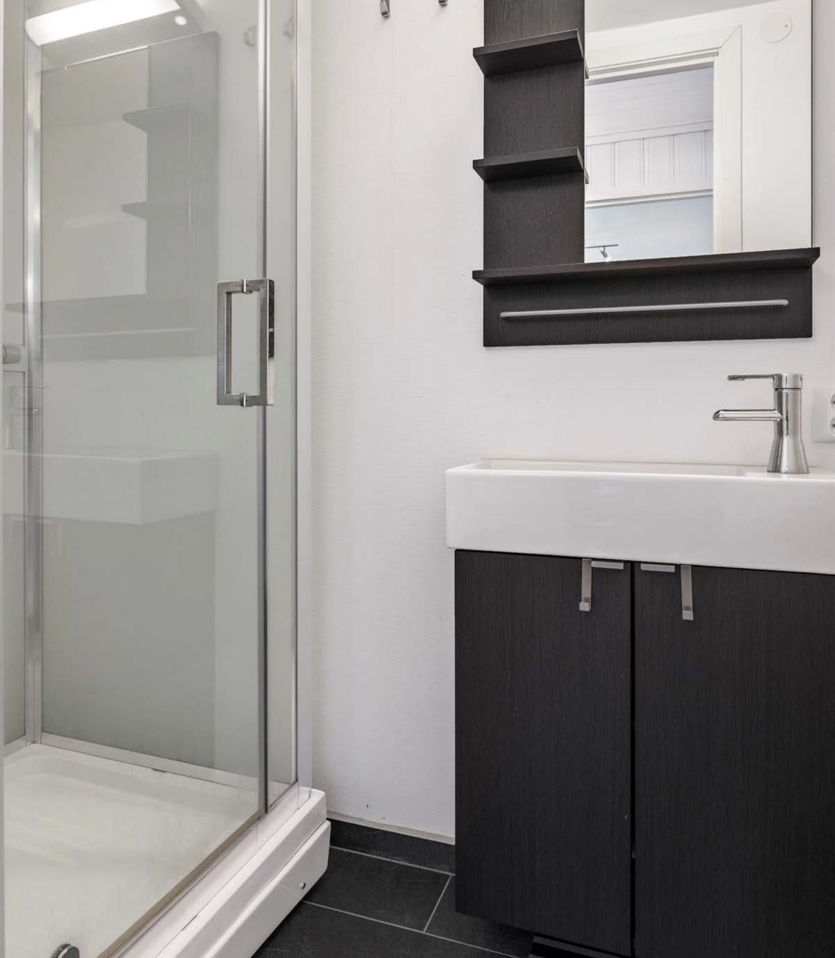
Utstyrt med vask i servant, toalett og dusjkabinett.
