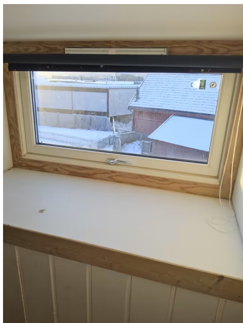
Bilde viser vindu med luftespalte.
