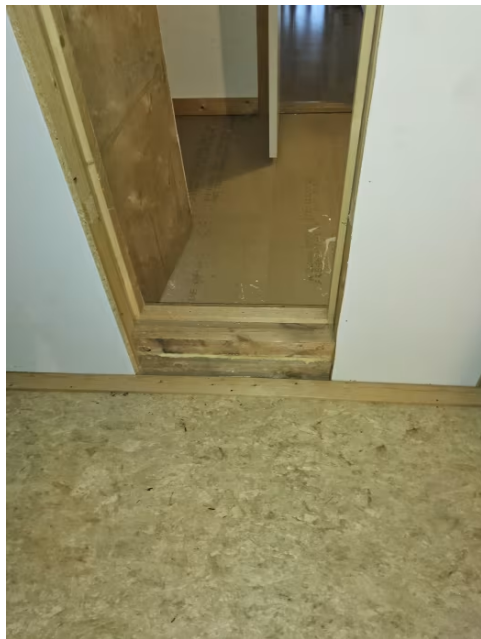
Bilde viser uferdig loft.
