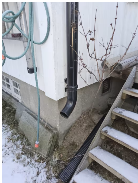
Bilde viser avslutning av taknedløp.
