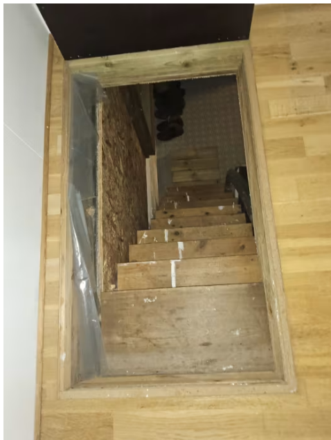
Bilde viser trapp til underetasjen.
