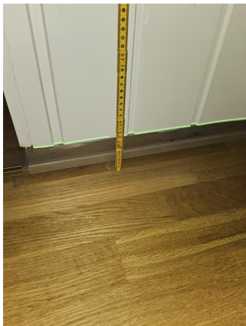
Bilde viser måling av etasjeskiller.
