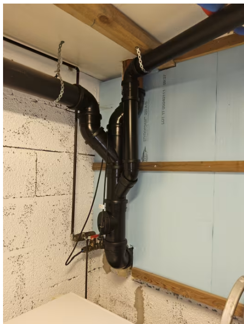
Bilde viser avløpsrør og stakeluke.
