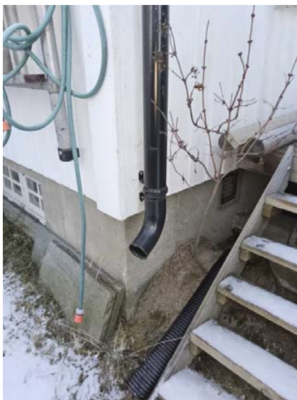
Bilde viser avslutning av taknedløp.
