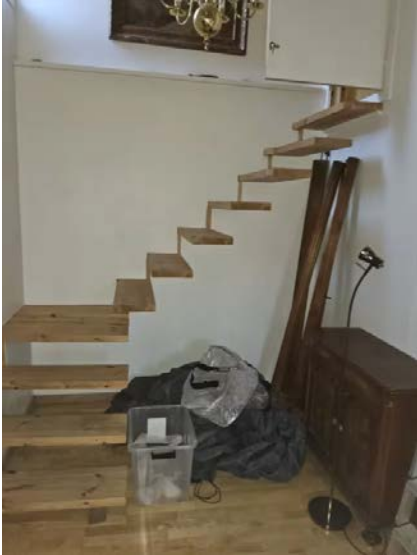
Bilde viser trapp til loft.
