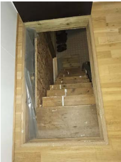
Bilde viser trapp til underetasjen.
