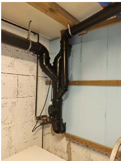
Bilde viser avløpsrør og stakeluke.
