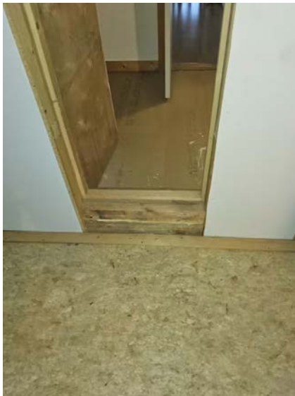
Bilde viser uferdig loft.
