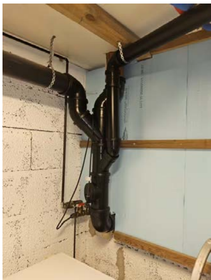
Bilde viser avløpsrør og stakeluke.
