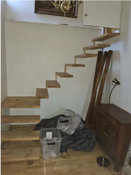
Bilde viser trapp til loft.
