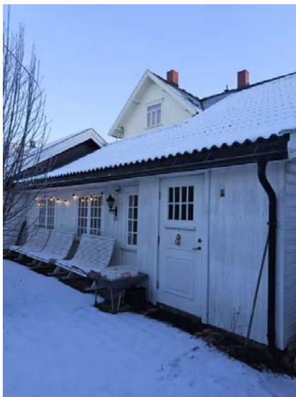
Bilde viser snødekt tak.
