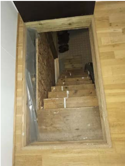
Bilde viser trapp til underetasjen.
