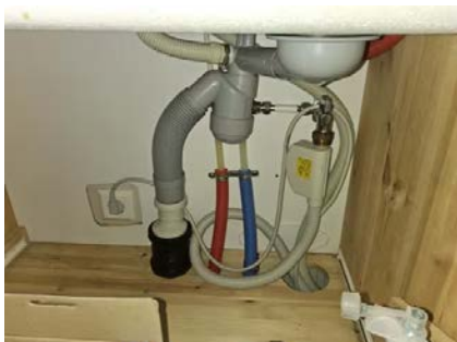
Bilde viser rørplegg under oppvaskkum.
