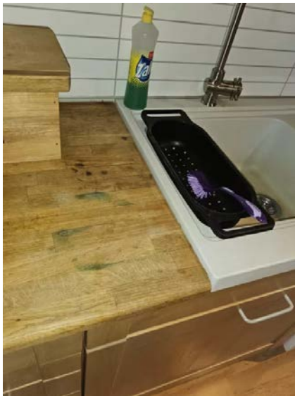
Bilde viser slitt benkeplate ved oppvaskkum.
