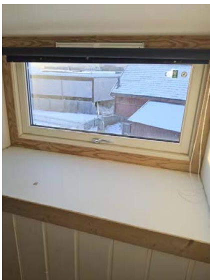
Bilde viser vindu med luftespalte.
