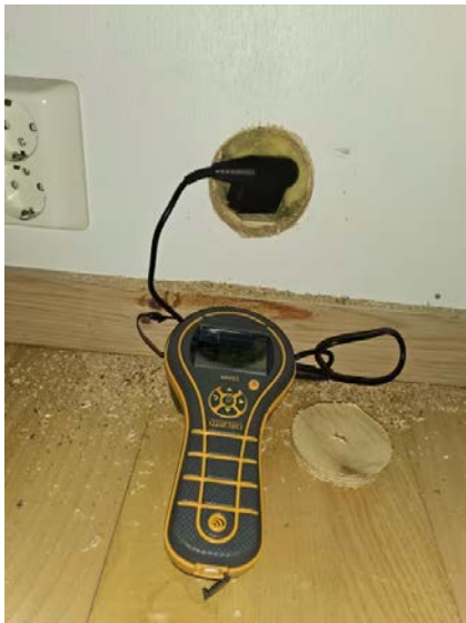
Bilde viser fuktmåling i tilstøtende rom til våtsone.
