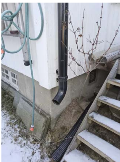
Bilde viser avslutning av taknedløp.
