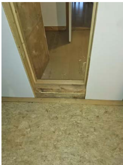
Bilde viser uferdig loft.
