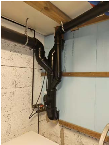
Bilde viser avløpsrør og stakeluke.
