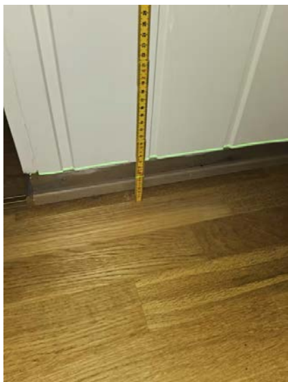
Bilde viser måling av etasjeskiller.
