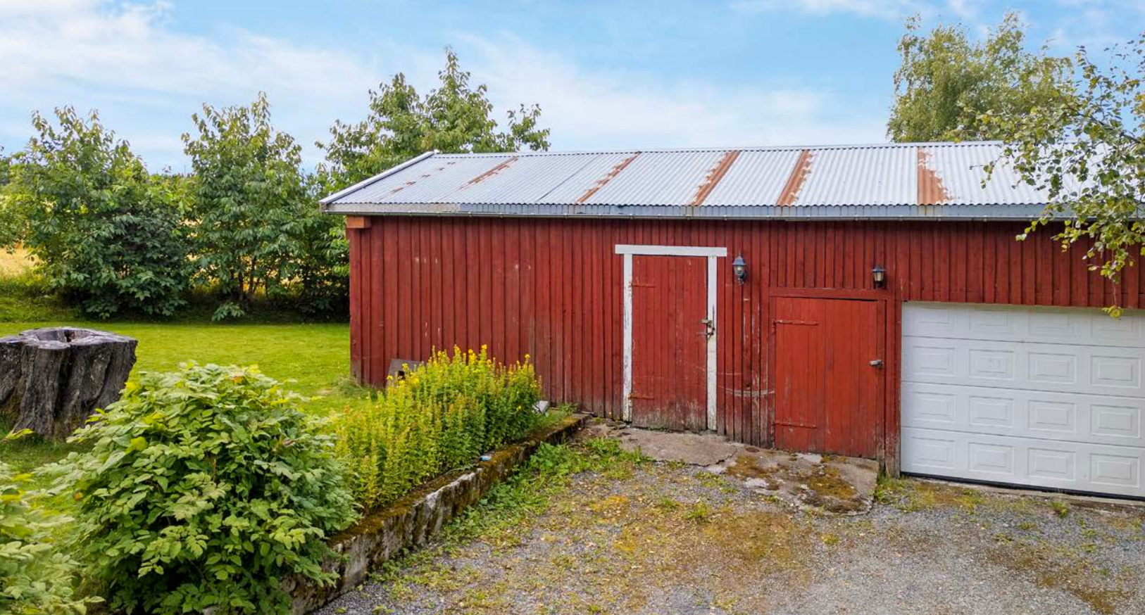
Uthus/ garasje på eiendommen.
