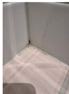
Mykfugen i dusjonen har løsnet enkelte steder, og kan til fordel skiftes ut.
