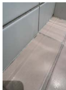
Mykfugen i dusjonen har løsnet enkelte steder, og kan til fordel skiftes ut.
