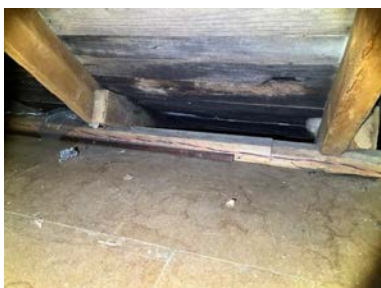
Eksempel på misfarging på korer.
