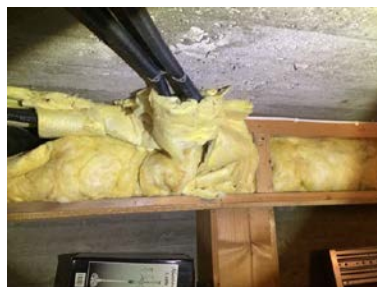
Store deler av vannrør er skjult av isolasjon.
