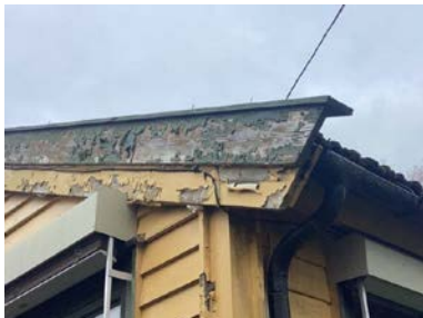
Eksempel på utvendig tilstand.
