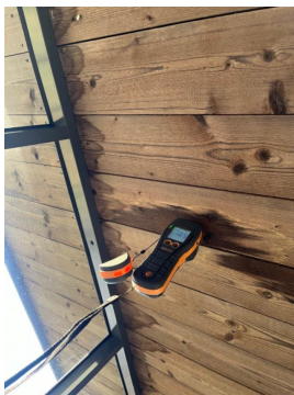
Skjolder langs vinduer innglasset terrasse- fuktmåling med normal verdi befaringen
