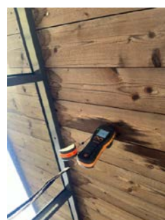
Skjolder langs vinduer innglasset terrasse- fuktmåling med normal verdi beferingen
