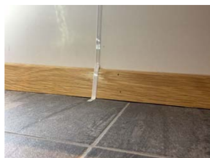
Føler for vannstopventil
