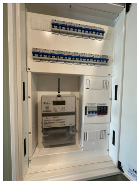
Sikringskap med automatsikringer.
