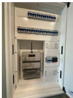
Sikringskap med automatsikringer.
