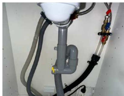
Røropplegg i kjøkkenbenk med Waterguard
