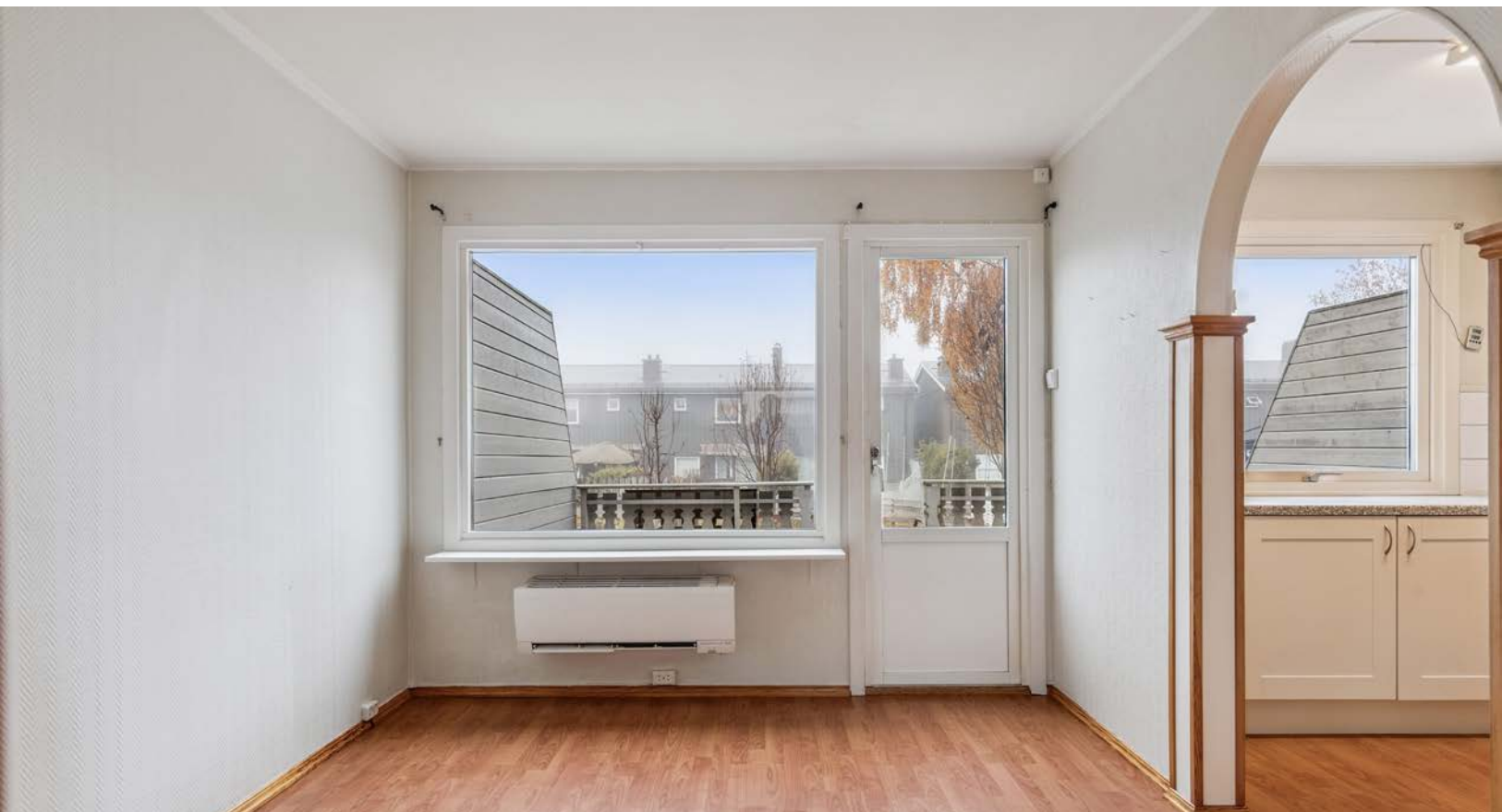
Det er montert varmepumpe i spisestue. Utgang til terrasse fra spisestuen.
