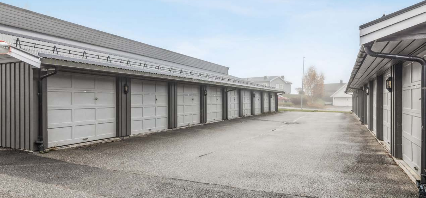
Garasje i rekke med leddport og opplegg for el-bil lader, abonnement.
