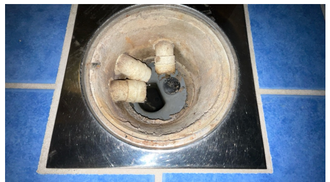
Kontroll av sluk.
