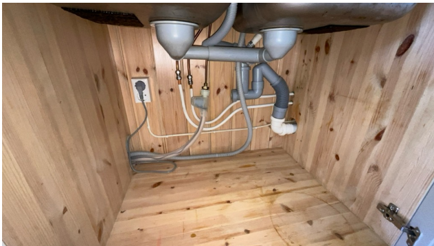
Besiktigelse av røropplegg.
