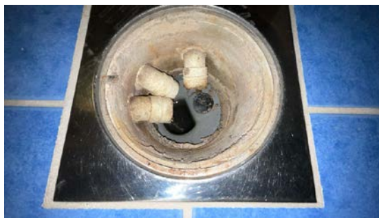
Kontroll av sluk.
