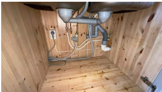
Besiktigelse av rørøpplagg.
