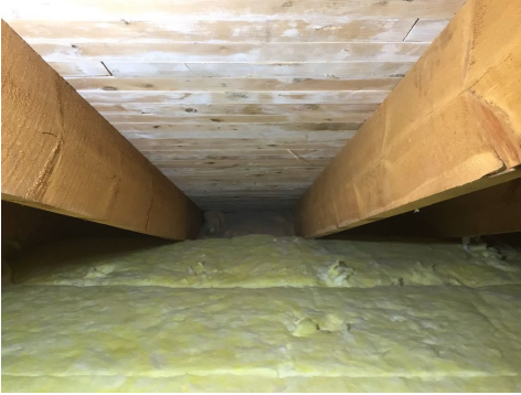
Isolert ut mot undertak i nedkant
