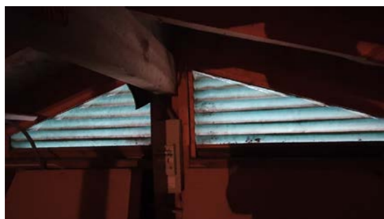
Luft ventil i gavli
