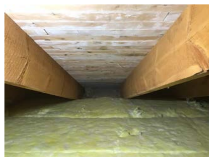
Isolert ut mot undertak i nedkant
