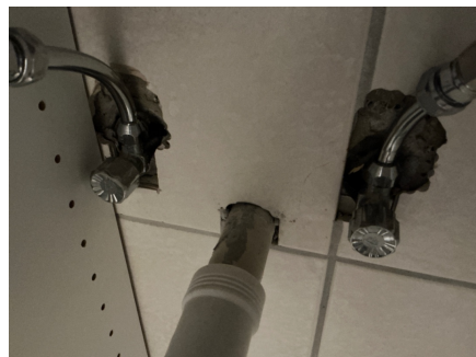
Utette rørgjennomføringer
