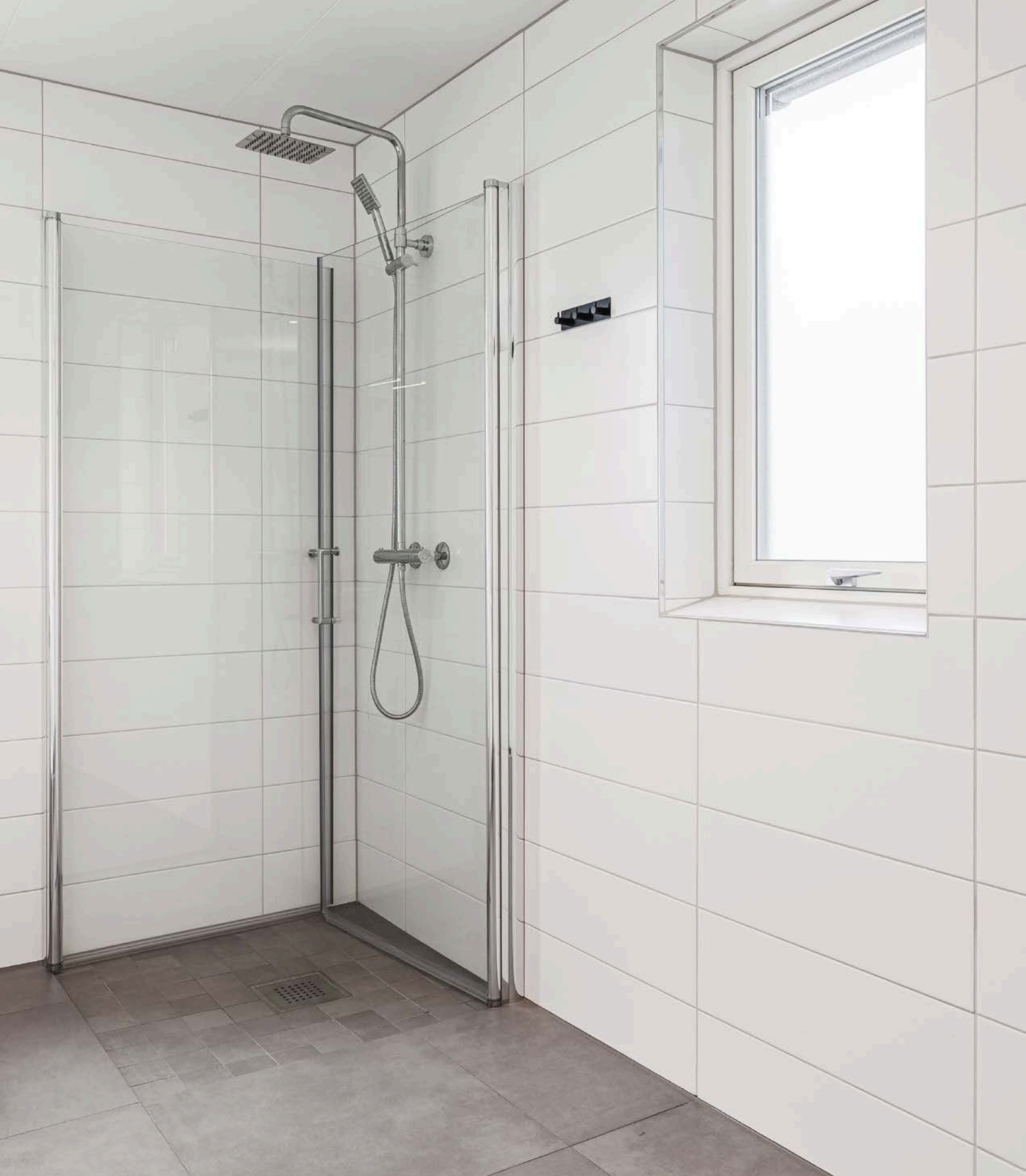
Dusjhjørne med innfellbare dusjdører og veggmontert dusjbatteri med regnfall. Det er opplegg for vaskemaskin på badet.
