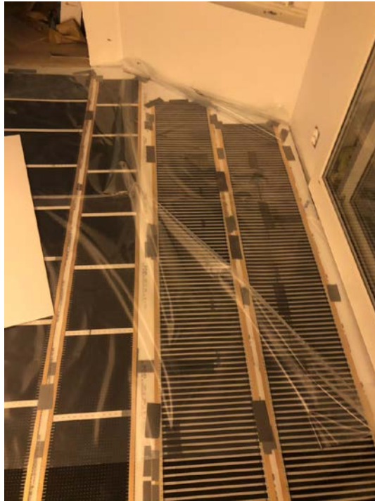
Skjema: "Skjult varme dokumentasjon: Varmefolie Stue + Kjøkken" Filnavn: A3C5B9A8-376C-4910-A6ED-BEBD57EDC00B.jpg
