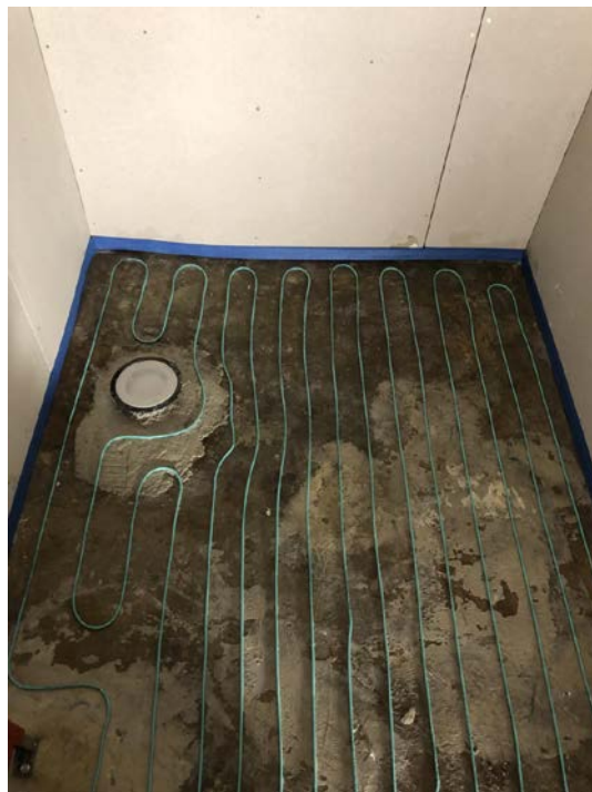
Skjema: "Skjult varme dokumentasjon: Varmekabel Bad" Filnavn: C1CB9F90-7122-460B-A194-CA0C9D9378E6.jpg
