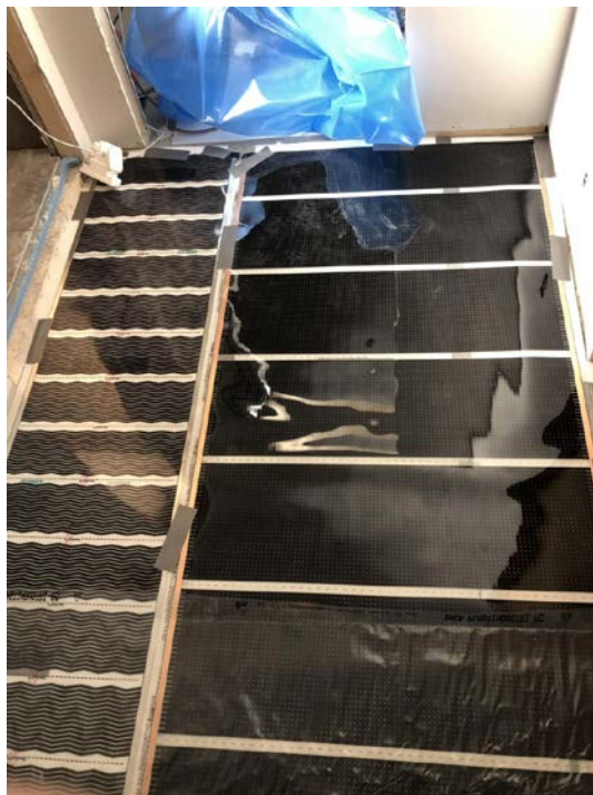
Skjema: "Skjult varme dokumentasjon: Varmefolie Gang" Filnavn: 57383FEB-BCFF-4D96-8401-674CF3788C44.jpg
