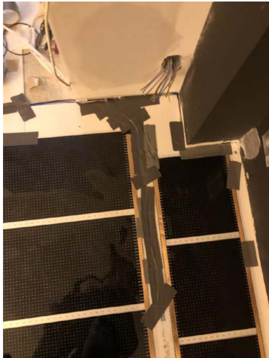
Skjema: "Skjult varme dokumentasjon: Varmefolie Stue + Kjøkken" Filnavn: 1552CEFD-C7D1-4D6E-80C1-69A7A83082E0.jpg
