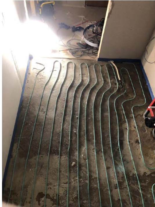
Skjema: "Skjult varme dokumentasjon: Varmekabel Bad" Beskrivelse: Varmekabel bad, Filnavn: 464D64C6-53BB-4875-9CE9-7F84179E44C1.jpg
