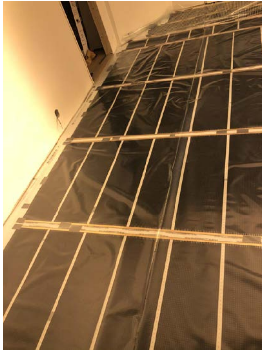
Skjema: "Skjult varme dokumentasjon: Varmefolie Stue + Kjøkken" Filnavn: 76C6EE74-5A38-45FB-AFEA-851D3EABDA89.jpg
