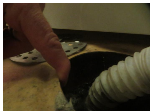
Ikke klemt belegg i sluk.
