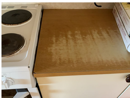
Skader på overflater.
