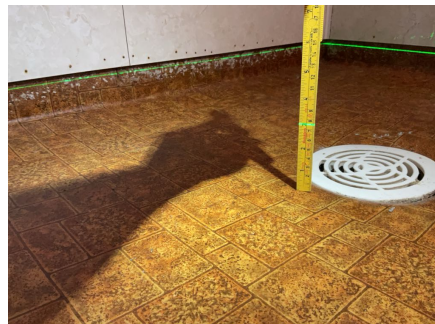
Målt fall til sluk: 26mm.
