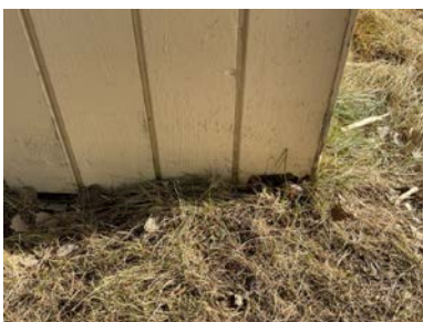
Lav høyde mellom grunnen og kledning, risiko for skader. Anbefalt høyde mellom terreng og kledning er 30 cm.
