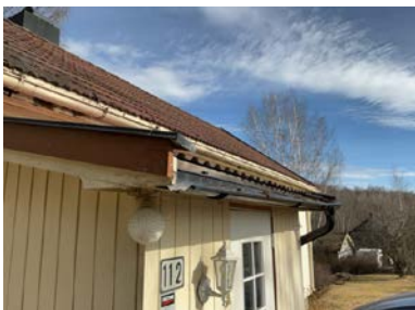
Takrenner har blitt bøyd, sannsynligvis som følge av snøras og endelokk mangler.
