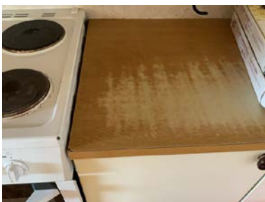
Skader på overflater.
