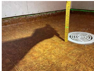
Målt fall til sluk: 26mm.
