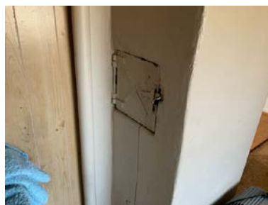
Sotluke plassert på kjøkken.
