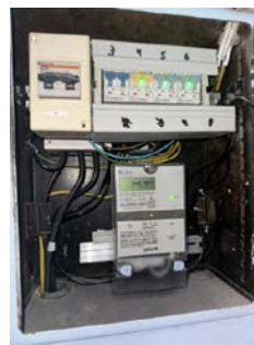
Sikringskapp med automatsikringer.
