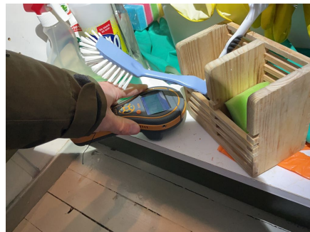
Svelling på bunnplate benkeskap, fuktstørkede viste normale verdier.
