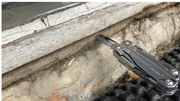
Råteskadet vindu.
