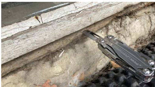
Råteskadet vindu.
