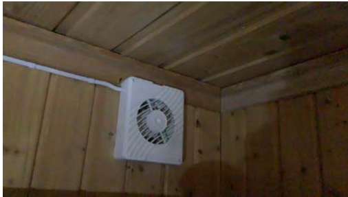
Defekt avtrekksvifte.
