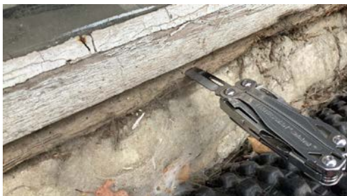
Råteskadet vindu.
