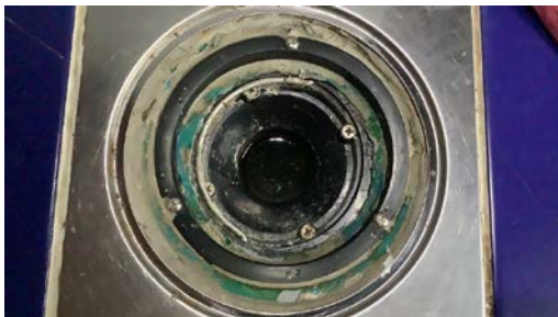
Plastsluk, og det er synlig smøremembran ført under slukets klemring.
