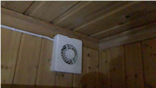
Defekt avtrekksvifte.
