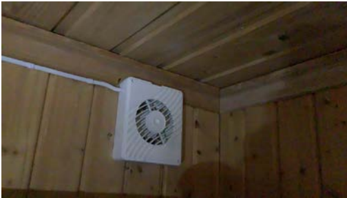
Defekt avtrekksvifte.
