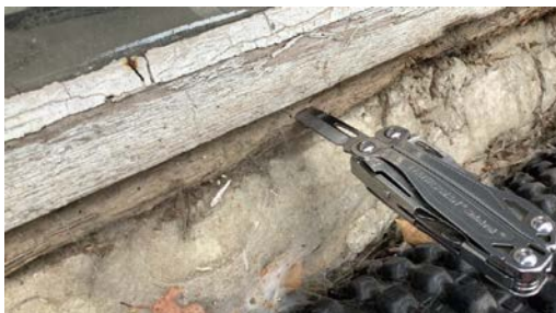
Råteskadet vindu.
