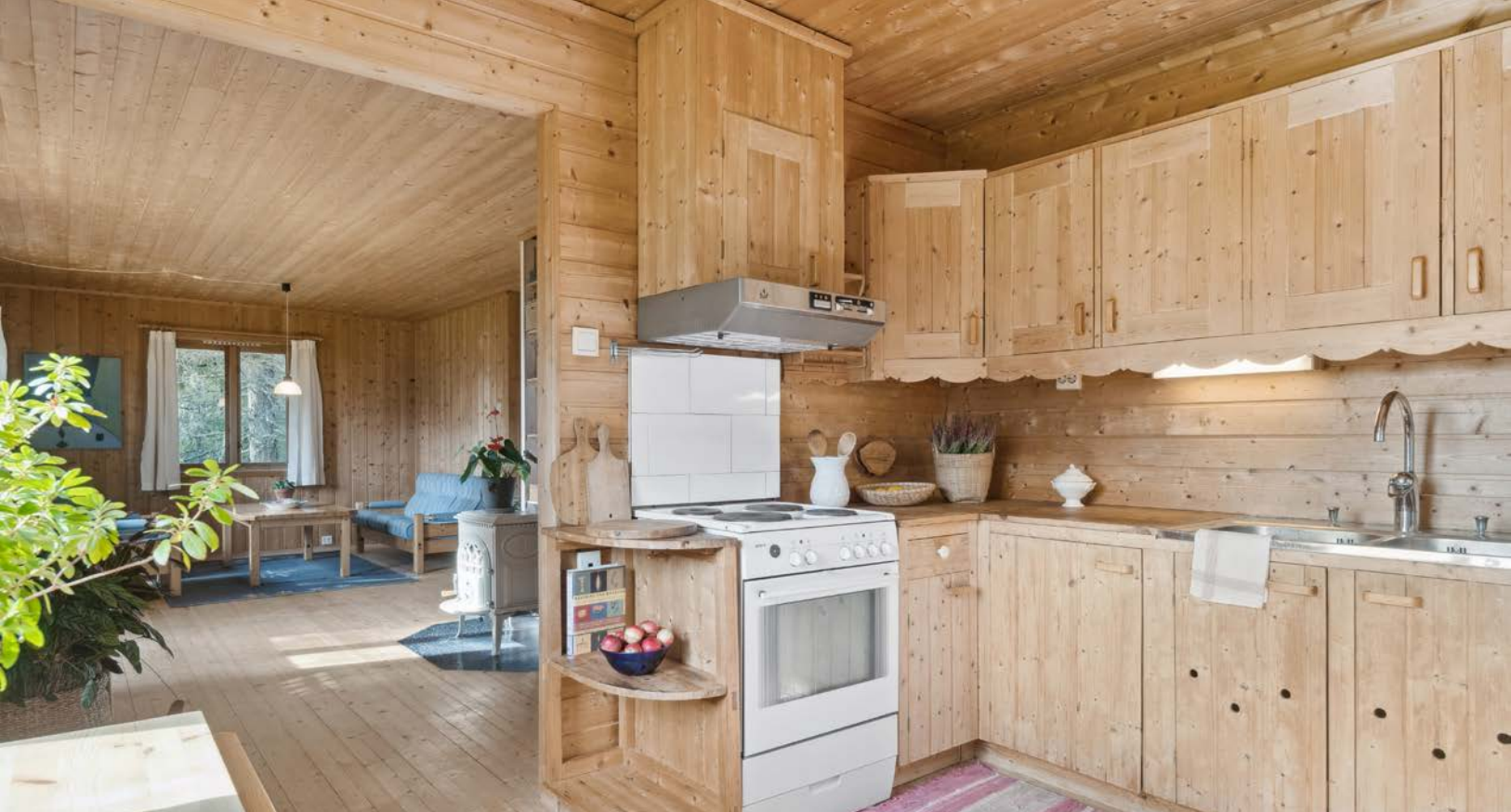
Kjøkkeninnredning som plassbygd av tre med litt profilerte fronter og heltre benkeplate. Hel stålopp på oppvaskbenk.
