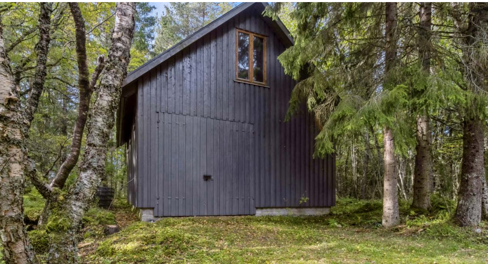
Uthus/garasje bygd ca. 1990 med støpt gulv. Romhøyde ca. 2,97 m. Med dobbel labankport mot gårdsplass. Innlagt 3-fas strøm. Uthuset generelt med bra stand iflg takstmann. Garasjen går over 2 etasjer (ikke trapp opp)
