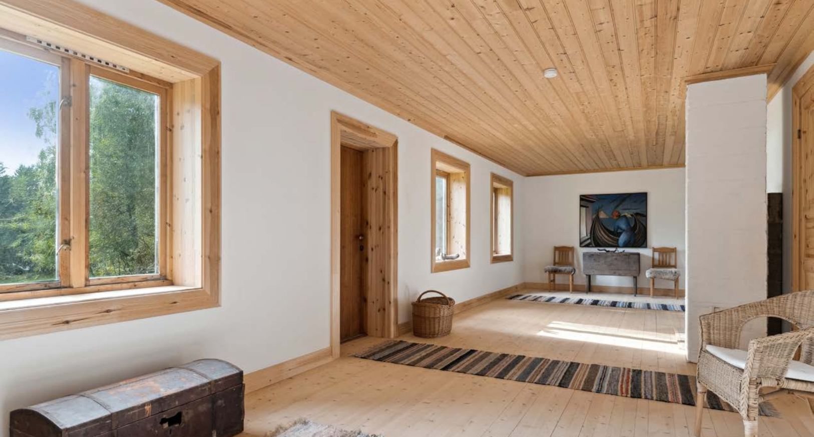
Kjellerstue innredet i nyere tid. Murer er etterisolert noe som vises på brede vindusforinger. Tregulv og malt overflate på vegger. Panel i himling.
