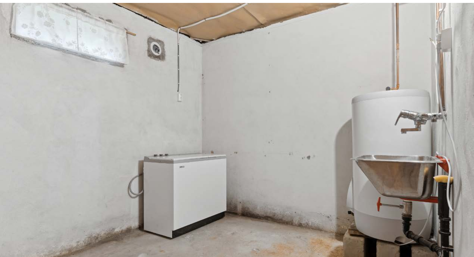
Et rom med skyllekum og bereder med mulighet som vaskerom. Videre medfølger toppmatet vaskemaskin med trommel sentrifugering (kjeller).
