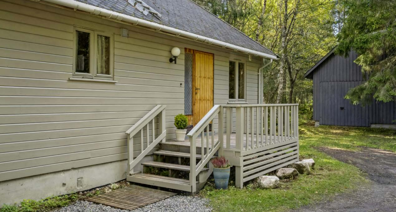
Inngangsparti med liten altan. Rekkverket er nylig malt.
