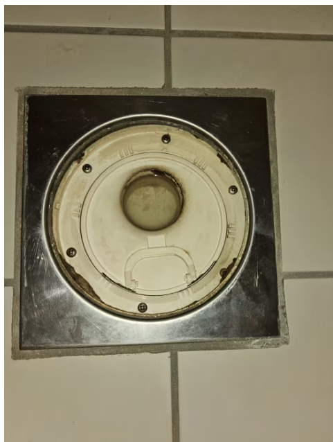
Bilde viser sluk på bad.
