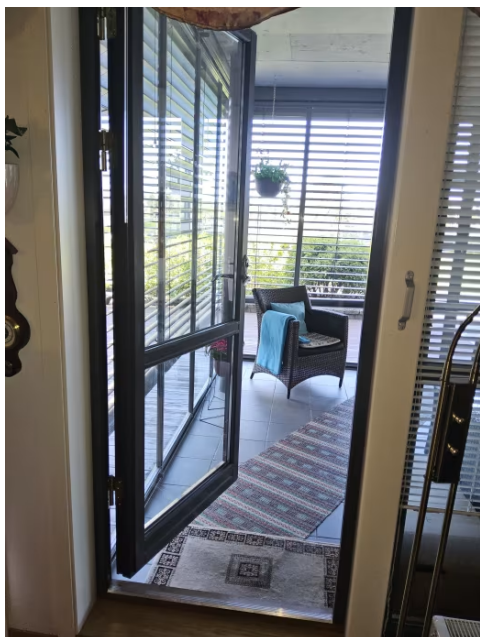
Bilde viser balkongdør.
