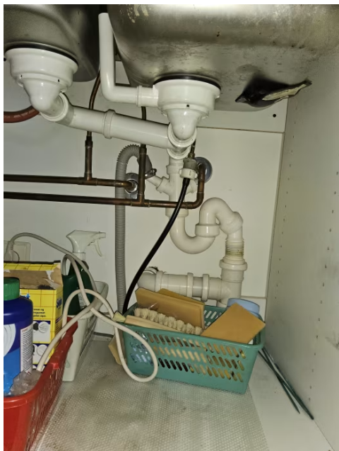
Bilde viser avløpsrør under oppvaskkum på kjøkken.
