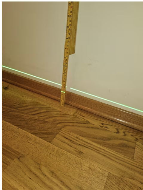
Bilde viser måling av etasjeskiller.
