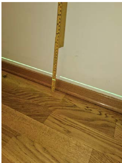
Bilde viser måling av etasjeskiller.
