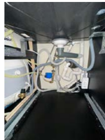
Røropplegg i kjøkkenbenk med Waterguard
