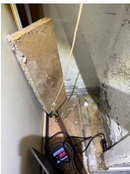
Bildet viser utført måling under sponplate i oppført gulv i boden innenfor soverommet.
