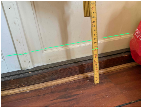
Bildet viser måling ved verandadør.
