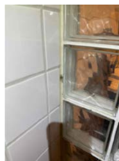
Bildet viser elastisk fugemasse (silikonfuge) med synlig svertesopp.
