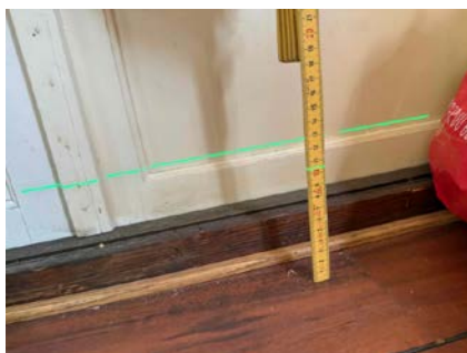
Bildet viser måling ved verandadør.
