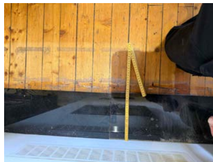
Bildet viser ildfast plate under ildsted i 1. etasje som ikke dekker minst 30 cm foran ildstedet.
