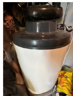
200 l varmtvannsbereeder, plassert i teknisk rom.
