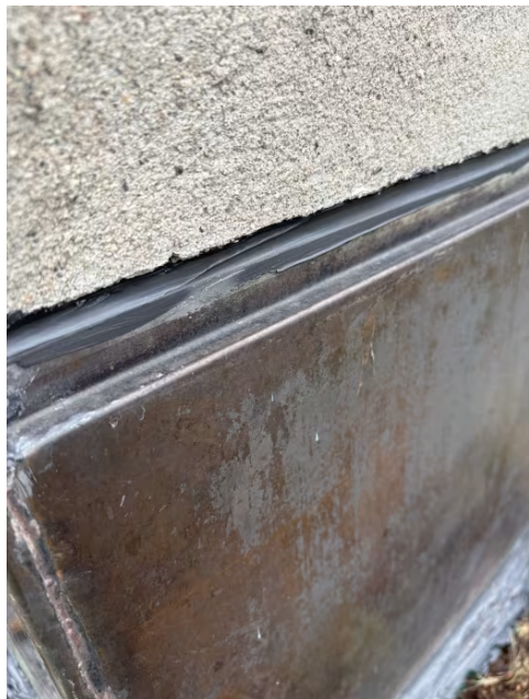
Utbedring beslag rundt pipe.
