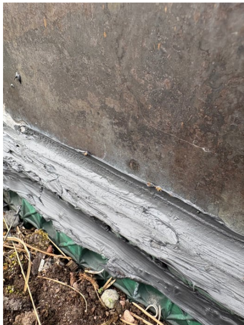
Utbedring beslag rundt pipe.
