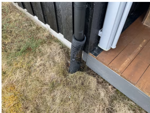
Bortledning av vann
