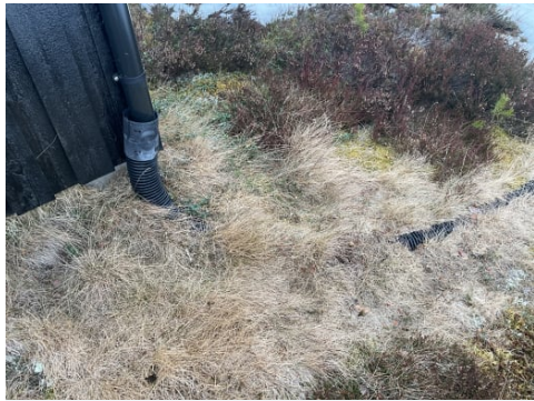
Bortledning av vann
