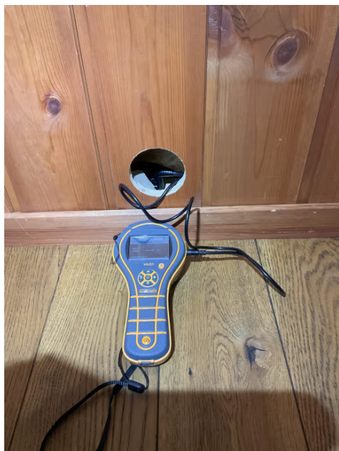
Hulltaking i tilstøtende rom.
