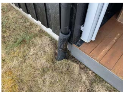
Bortledning av vann
