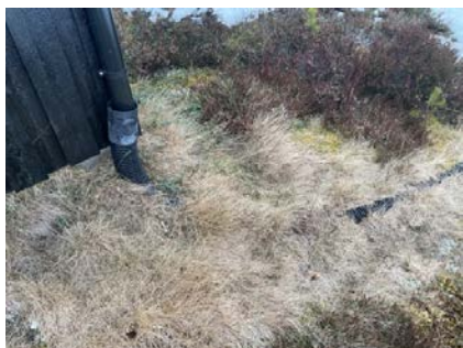
Bortledning av vann
