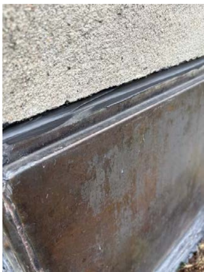
Utbedring beslag rundt pipe.
