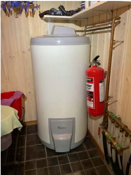
Varmtvannsbereder
