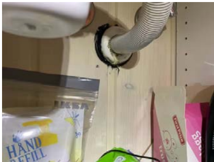
Fugemasse rundt avløp til servant.
