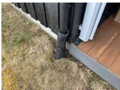
Bortledning av vann
