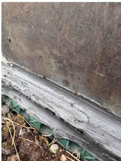
Utbedring beslag rundt pipe.
