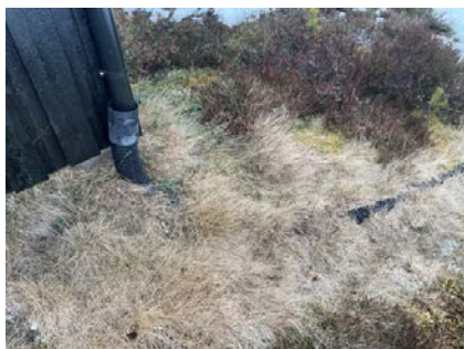
Bortledning av vann
