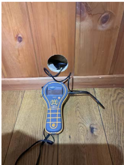
Hulltaking i tilstøtende rom.
