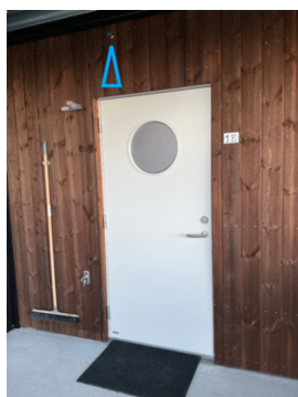
Røykvarsler tilkoblet sentralvarsling for borettslaget
