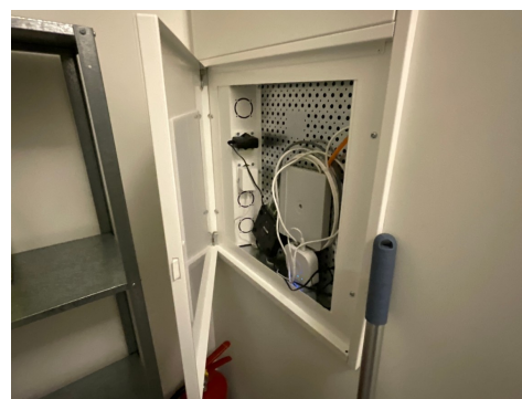
Dataskap med fiberbredbånd.
