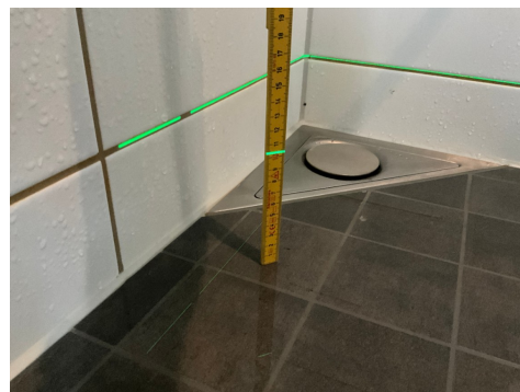
Måling av fallforhold på gulv. Topp laserstrek viser 105mm ved siden av sluk. Gulvoverflate er målt 2mm lavere enn sluk.
