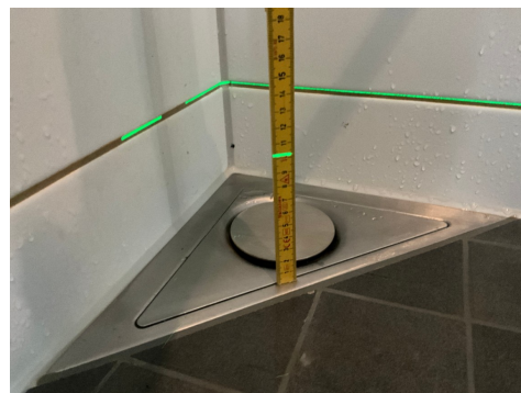
Måling av fallforhold på gulv. Topp laserstrek viser 103mm ved sluk.
