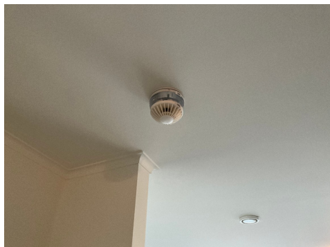
Røykvarsler tilkoblet sentralvarsling for borettslaget
