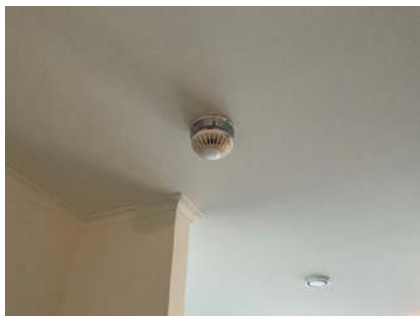
Røykvarsler tilkoblet sentralvarsling for borettslaget
