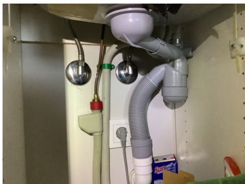
Rør i kjøkkenbenken
