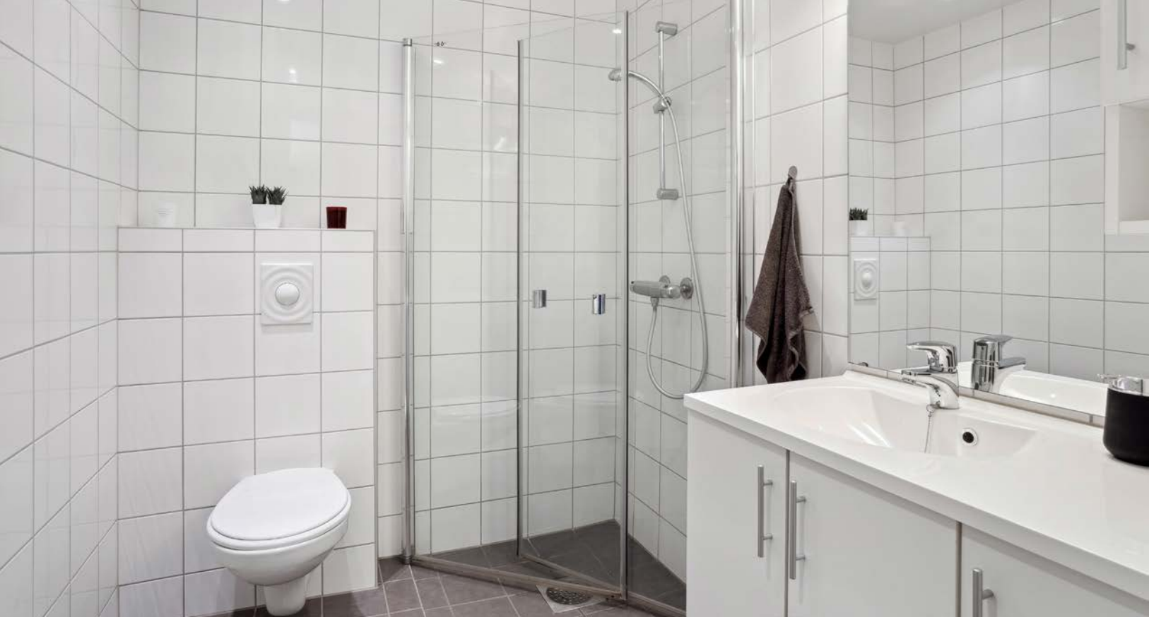
Fint flislagt bad med gulvvarme.
