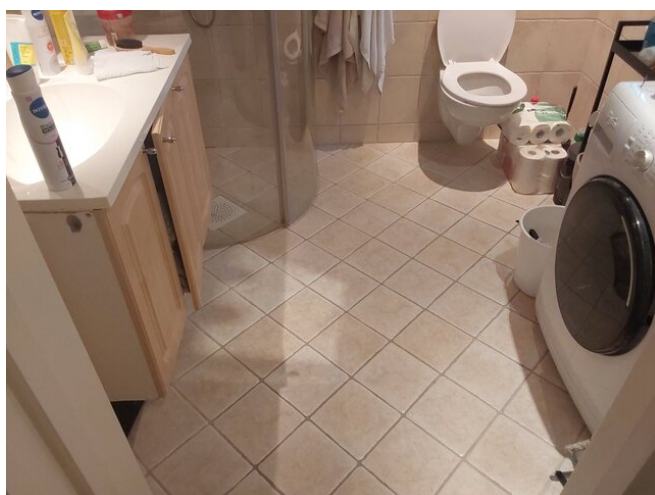
Leilighet 2 etg Bad. Flis på gulv og vegg. Dusjes rett på gulv.
