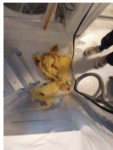
Bad leilighet 1 etg. Misfarget isolasjon fra området mot pipe.
