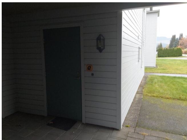
Inngang leilighet 1 etg
