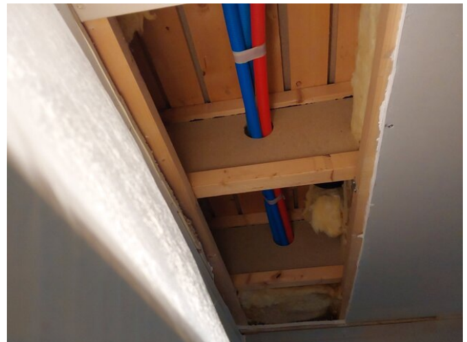
Bad leilighet 1 etg. Ingen synlige vannmerker eller tegn til lekkasje fra rør.
