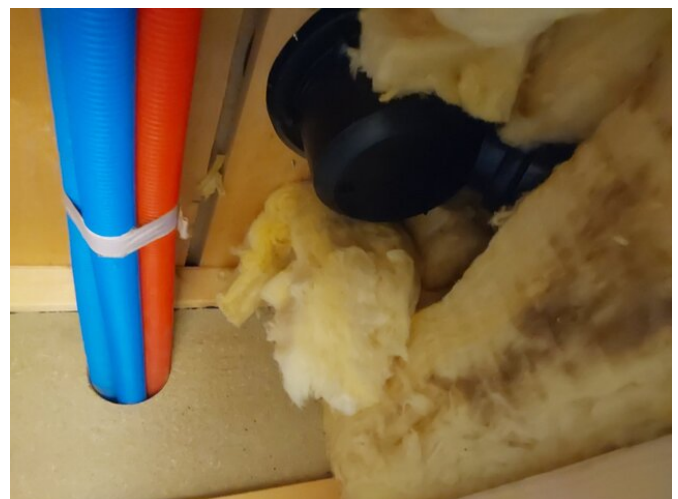
Bad leilighet 1 etg. Fuktsøk. Ingen tegn på lekkasje fra vannrør PEX. Ingen tegn til lekkasje fra sluk bad 2 etg.
